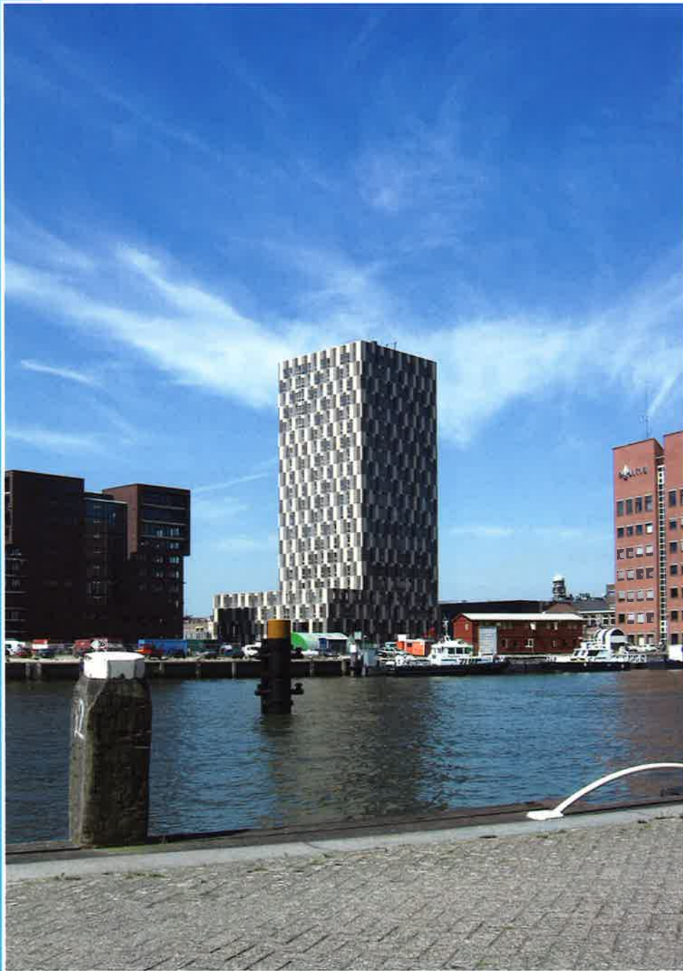
Witte de With-gebouw, Müllerpier, Rotterdam (EGM Architecten)
