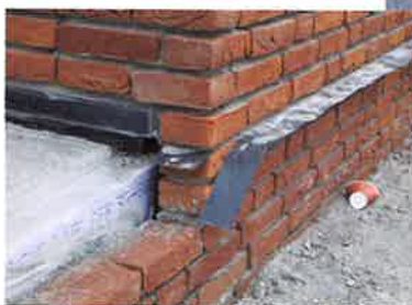
Foto 5: barrière tegen optrekkend bodemvocht
